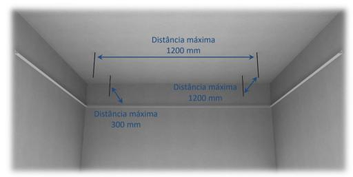
**3.** Aplicar los perfiles de suspensión 00PG en las varillas roscadas, mediante uso de elementos de fijación adecuados (casquillos, tuercas, etc..).
